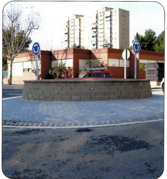
La nueva rotonda se ubica entre la avenida Burgos y la calle Zaragoza
