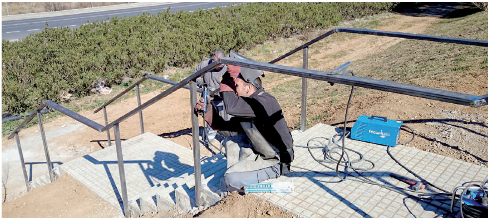
Entre les tasques que durà a terme el personal contractat hi ha reparacions i intervencions en la via pública.
