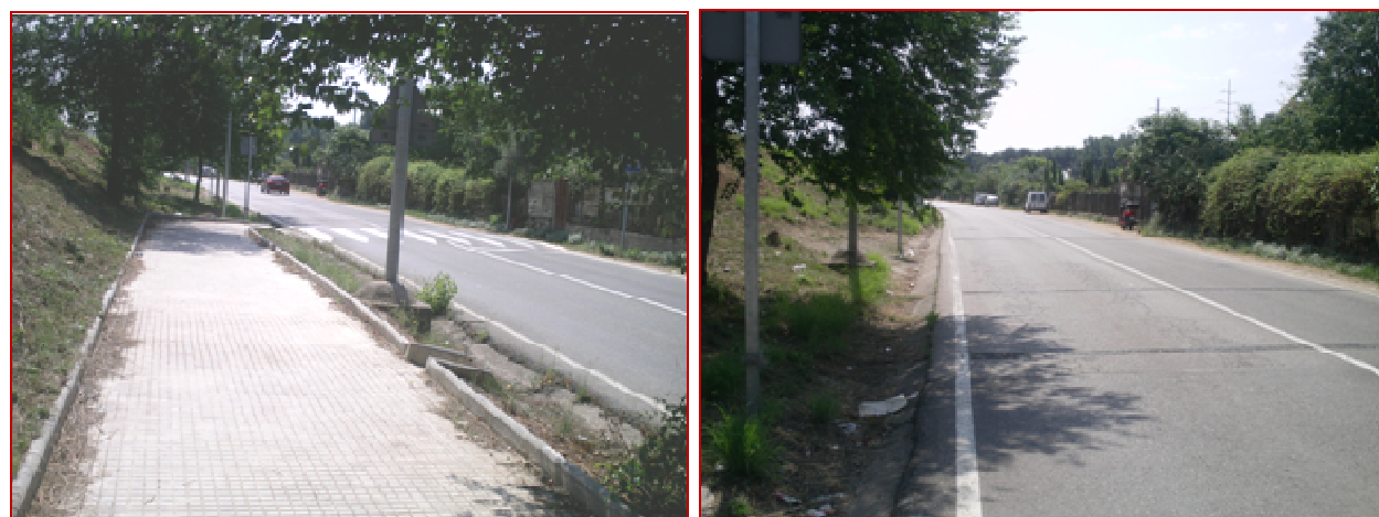
Fig. 3.2.5 Ctra. de Cerdanyola: oferta suficient (esquerra) i insuficient (dreta)
