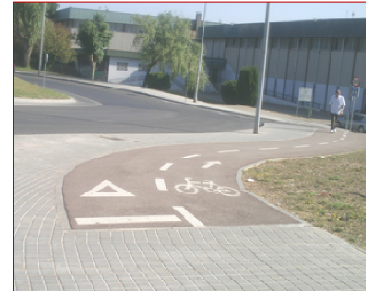
Fig. 3.3.1. Vorera-bici d'accés al Poliesportiu Badia del Vallès
